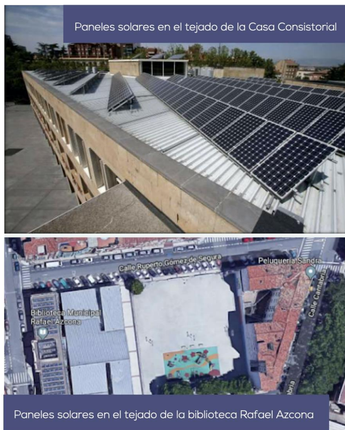
Figura 3. Paneles solares en edificios municipales
