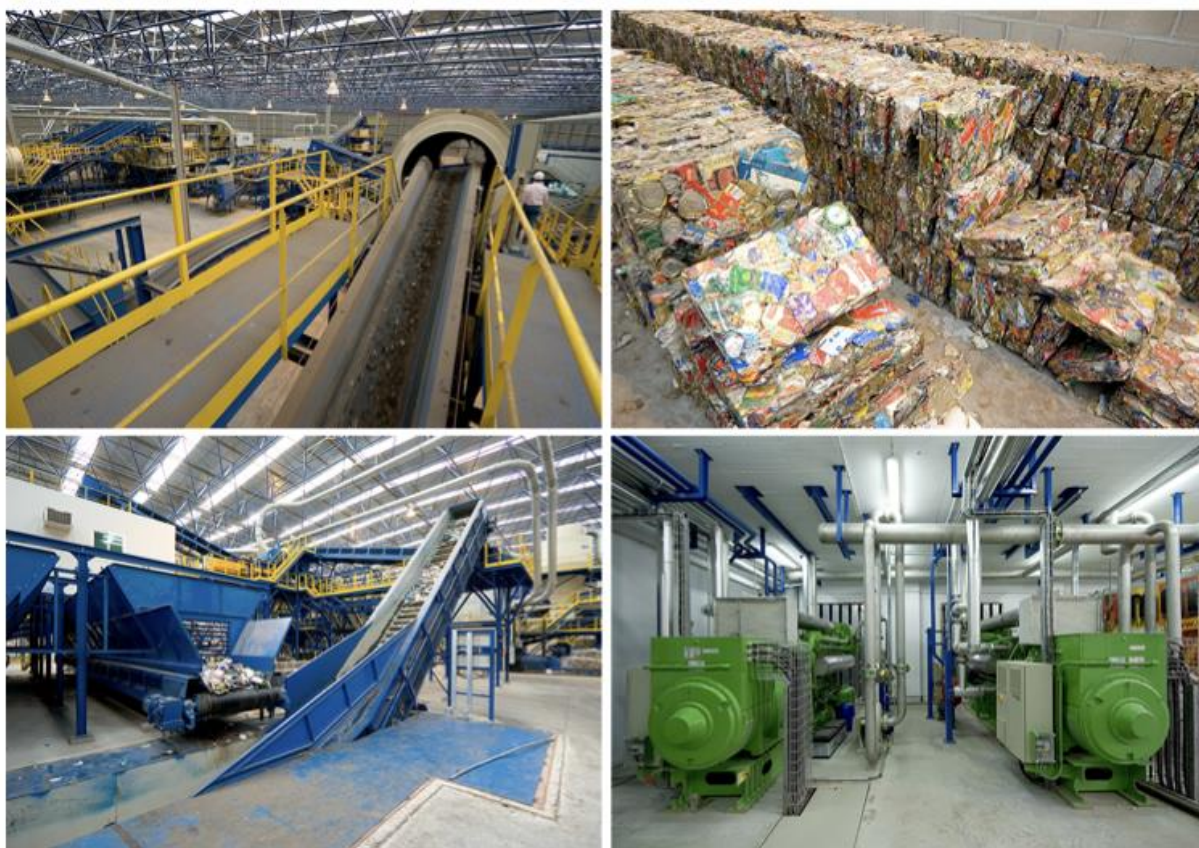
Figura 1. Ecoparque: Planta de tratamiento de residuos de La Rioja.
